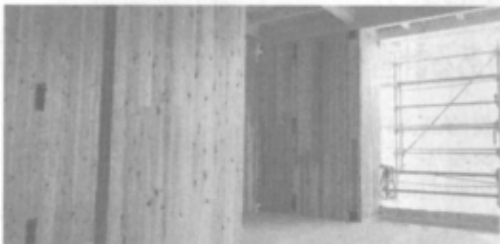
建築中の大東建託の木造4階建て賃貸(22年2月上棟時)
