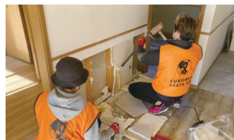
床上浸水した住宅の壁ボード撤去作業
