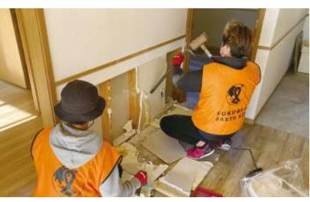
床上浸水した住宅の廊下部分床剥がし作業
