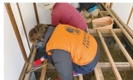
床上浸水した住宅の廊下部分床剥がし作業
